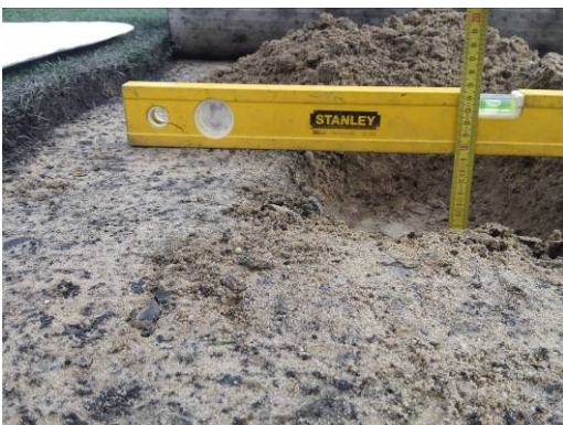
Laagdiktebepaling t.o.v. bovenzijde fundatie
