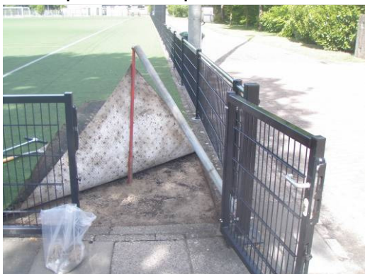
Hoek 2 t.p.v. onderhoudspoort NO hoek
