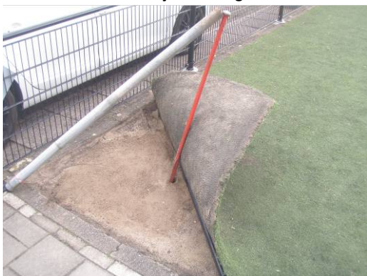
Hoek 1 t.p.v. onderhoudspoort NW
