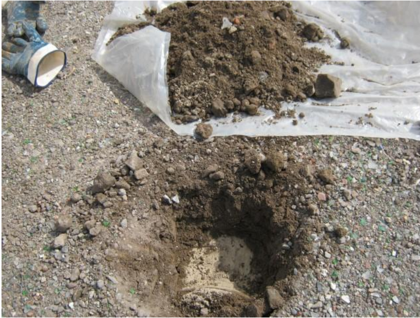
Foto 4: Halfverharding parkeerplaats Boring B02 (menggranulaat)
