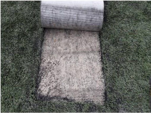
Zand-steagran fundatie onder toplaag
