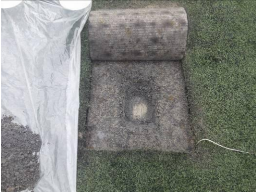
EBodemas fundatie onder toplaag
