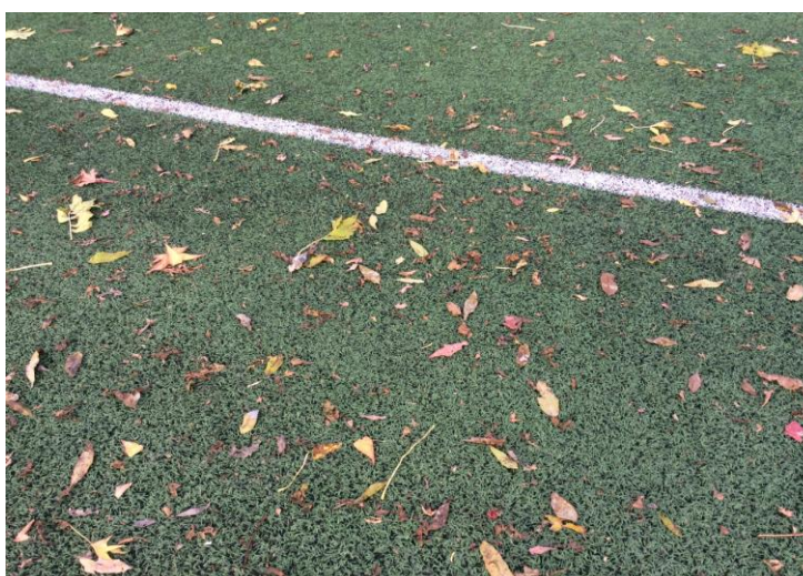
Rubbergranulaat in het veld
