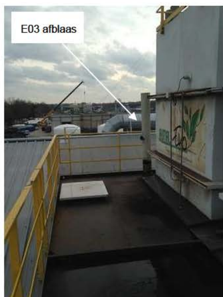
Ligging emissiebron E03 bovendaks, productiehal H, gesitueerd naast granulaatsilo.
