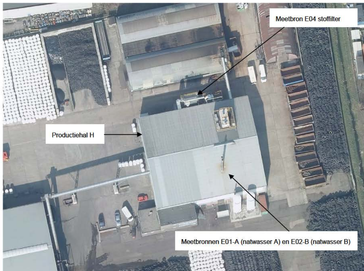
Situering meetbronnen E04 (stoffilter halafzuiging), E01-A (natwasser A) en E02-B (natwasser B).
