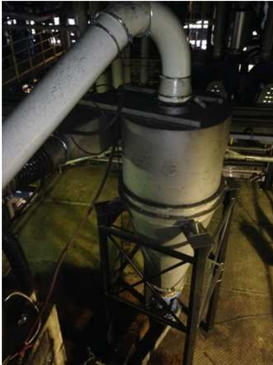
Cycloonafscheider ad E01-B (natwasser B) in pandig productiehal H.
