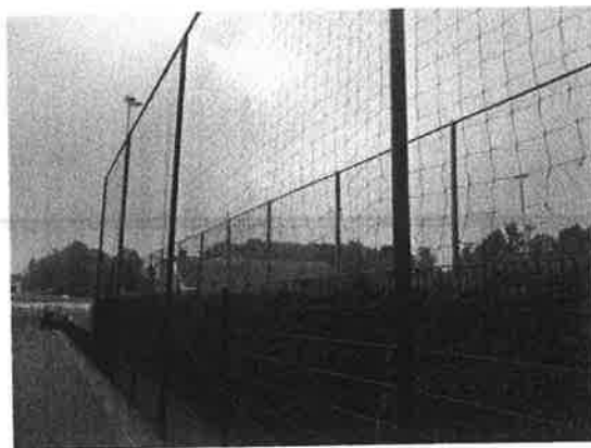
(afbeelding 8: gaten in het net van de ballenvanger)
